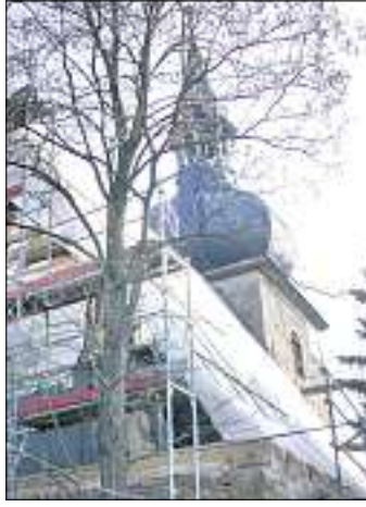
GERÜSTET: St. Johannes Baptiste bekommt ein neues Dach.
