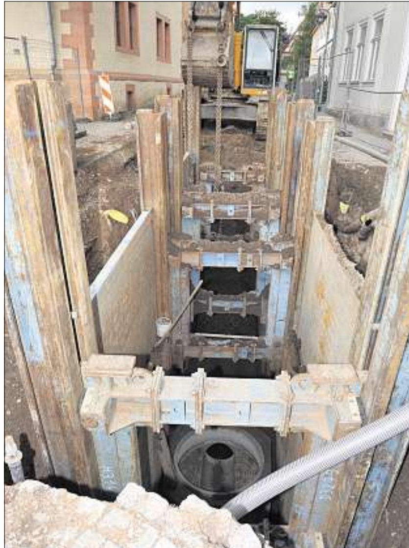
KANALBAU: Seit Ende vergangener Woche laufen die Arbeiten in der Straße am Markt. Zwischen 4,50 und 2 Meter tief kommt der Kanal von Obermarkt bis Adolf-Barth-Straße mit Gefälle in die Erde. Fotos (2): Harald Fahrholz
